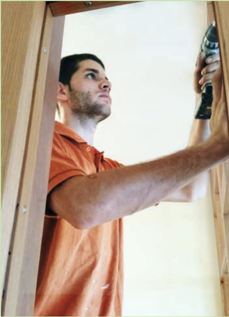
David Witzig bei der Demontage einer Trennwand.
