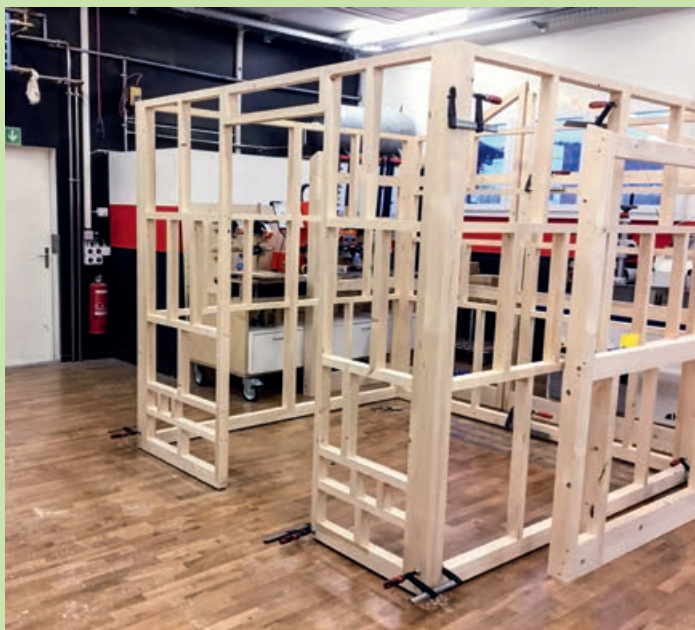
Gerüst der Sauna. Der Innenausbau muss durch die kleine Tür passen.
