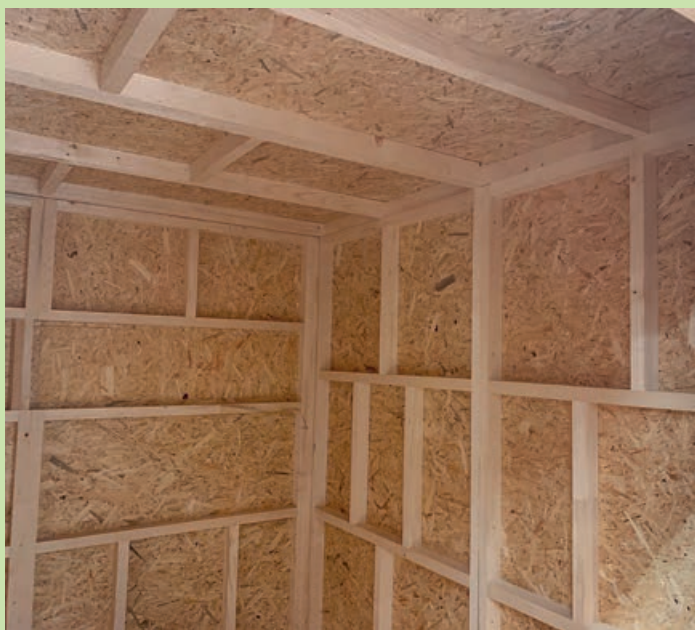
Das Saunagerüst nach Anbringen der Aussenverkleidung.
