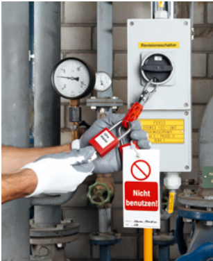
Regel 3 Anlage ausschalten und sichern.
