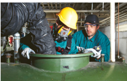
1 Schleifarbeiten in gereinigtem Tank: Ventilation und Atemschutz erforderlich
